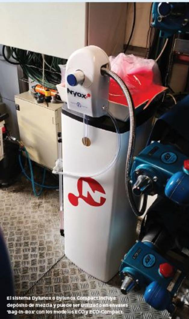
El sistema Dylunox o Dylunox Compact incluye depósito de mezcla y puede ser utilizado en envases 'Bag-In-Box' con los modelos ECO y ECO-Compact.
